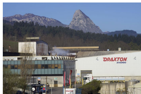
Instalaciones de Draxton en Atxondo
